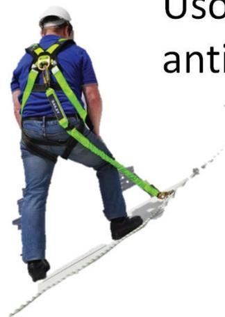
Uso de un sistema anticaídas
