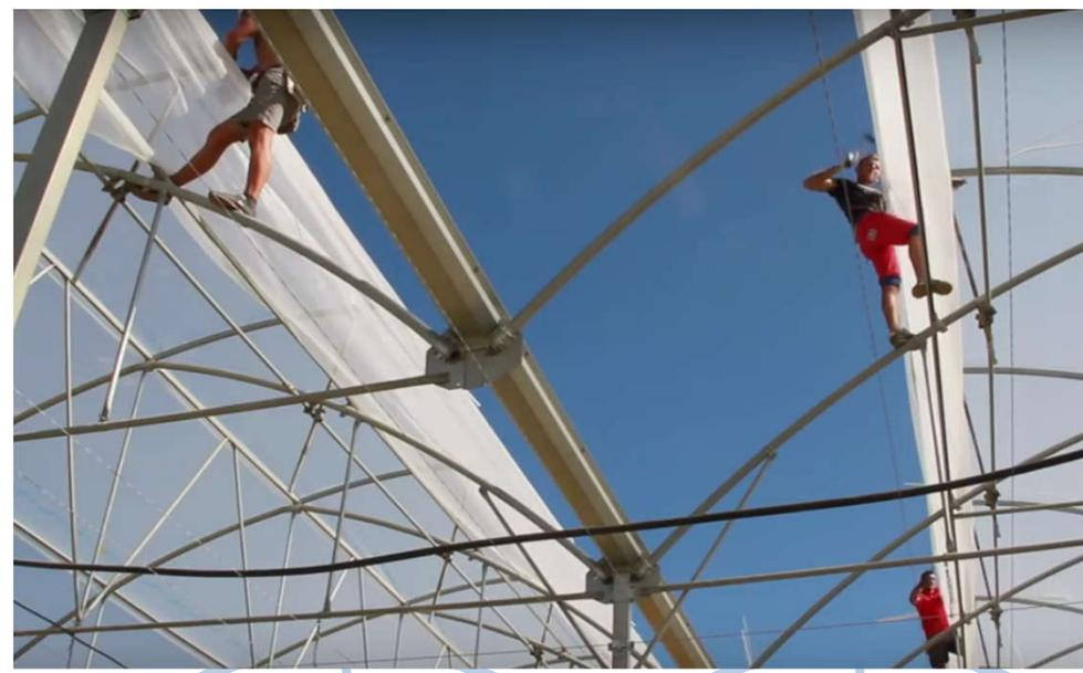
Tránsito por los elementos estructurales de la cubierta. Acceso por los arcos superiores del invernadero para la fijación del plástico.
