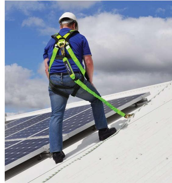
Un sistema anticaídas se compone de un dispositivo de anclaje (norma UNE-EN 795), un dispositivo de presión del cuerpo (arnés anticaídas UNE-EN 361 en este caso) y un dispositivo que conecte ambos. Éste puede ser:
