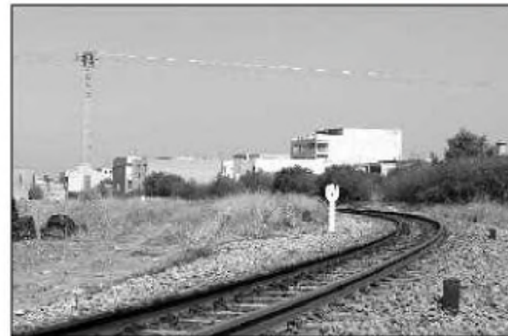
El tramo de la vía de FEVE en Los Nietos donde murió electrocutado ayer el trabajador
